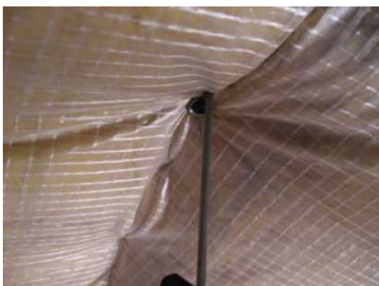
Perforace parozábrany kotevními prvky
